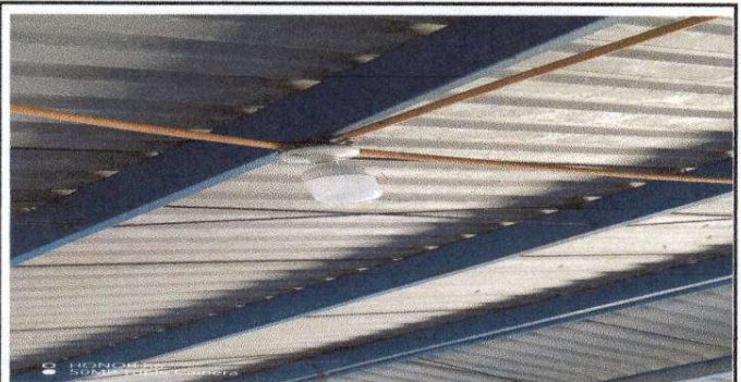
Foto 12: Sustitucion de lamparas tipo LED en todos los modulos.
