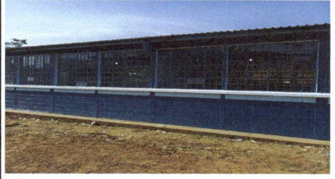
Foto 8: Pintura en muros exteriores del establecimiento.
