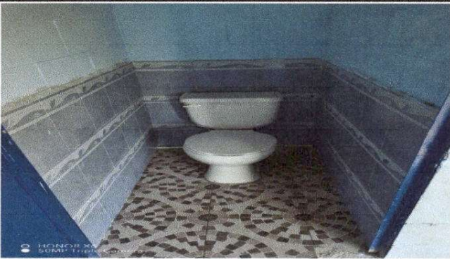
Foto 9: Sustitucion de inodoro del baño.
