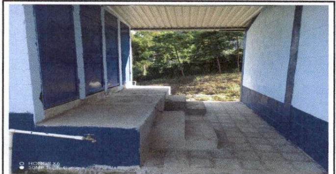
Foto 4: Reparación del piso de torta de concreto de los Baños.
