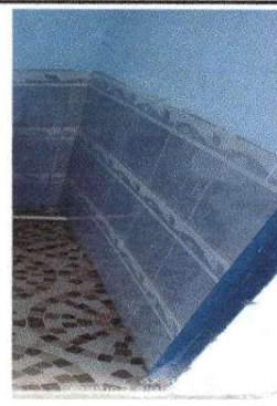
Foto 10: Sustitucion de tabique por azulejo en los baños.
